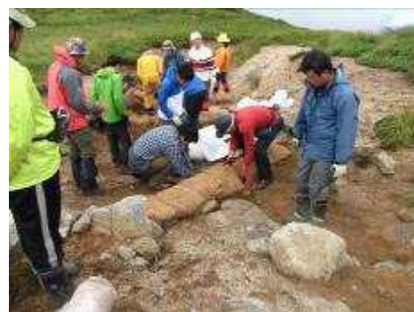
【ダムを造っているところ】
