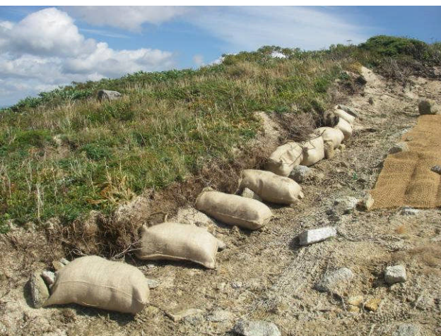
風除け目的として、試験的に土嚢袋を設置
