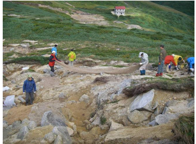
緑化ネットを敷設
