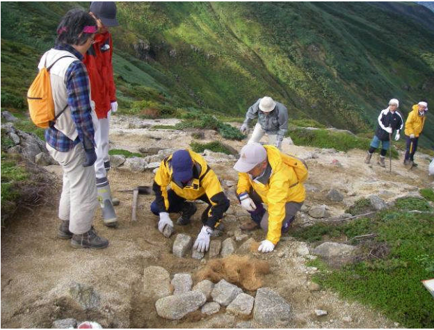
現地の転石を用いて、ステップとなる石を設置 (歩行路固定)
