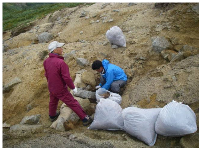
麻製土嚢袋を用いて土留め工を設置
