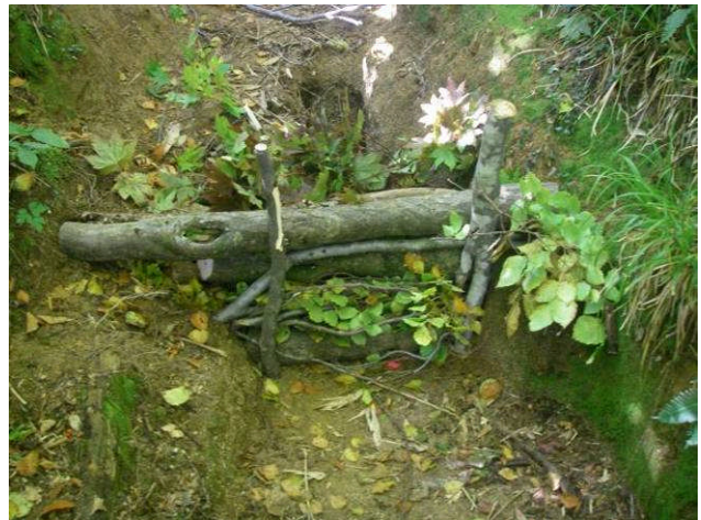
木組による土留め工を設置（丸森尾根）
