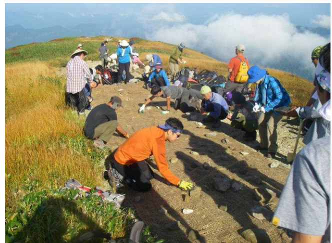
緑化ネットを敷設（梶川尾根・大規模裸地部）
