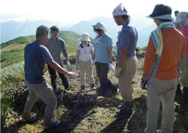
現地の転石を用いて土留め工を設置
