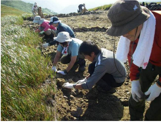
植生保護のため、登山道と植生部の際に石を設置
