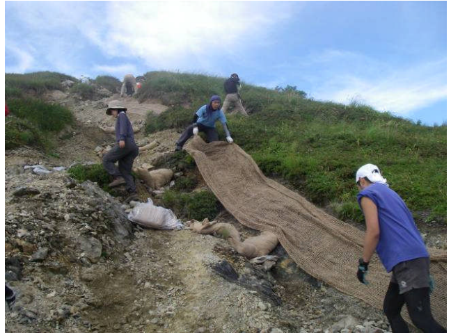
緑化ネットを敷設
