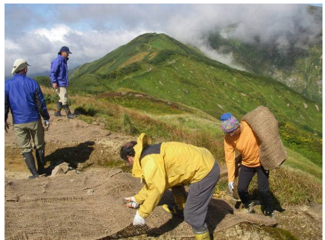
緑化ネットを敷設します
