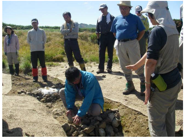
土留め工を設置します
